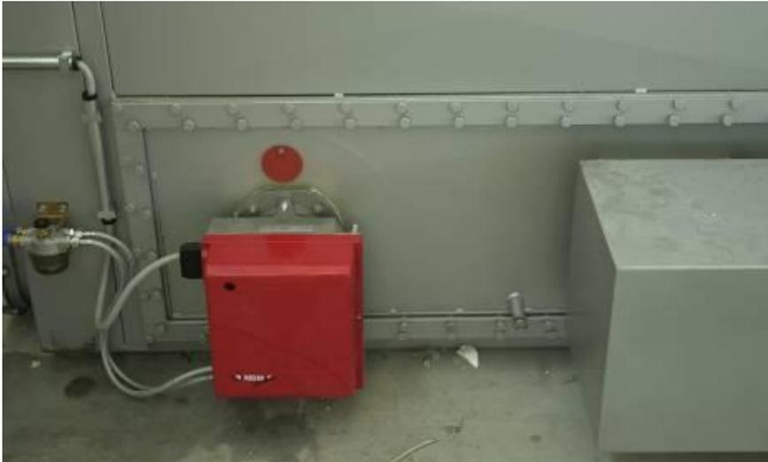
Il riscaldamento dello stadio di sgrassaggio sarà garantito da scambiatore a fascio tubiero immerso in acciaio inox corredato di bruciatore a gas metano monostadio e rampa di sicurezza
