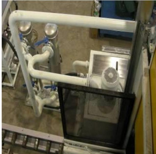
N°2 filtri esterni a cestello in acciaio inox AISI 304 con sacco filtrante interno in NYLON facilmente estraibili.
